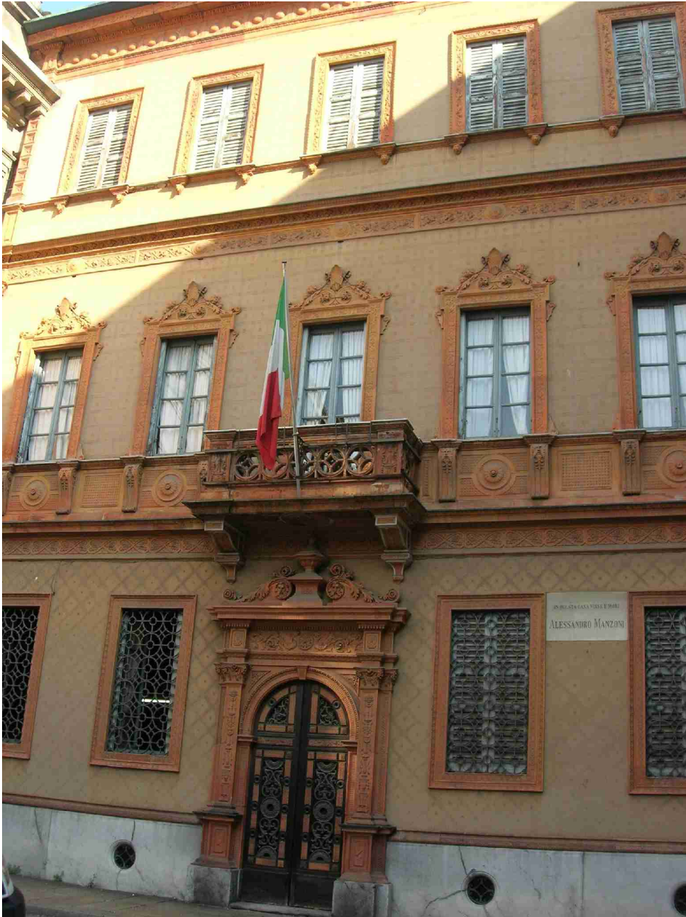
Facciata della casa di Alessandro Manzoni, Piazza Belgioioso ang. Via Morone.
